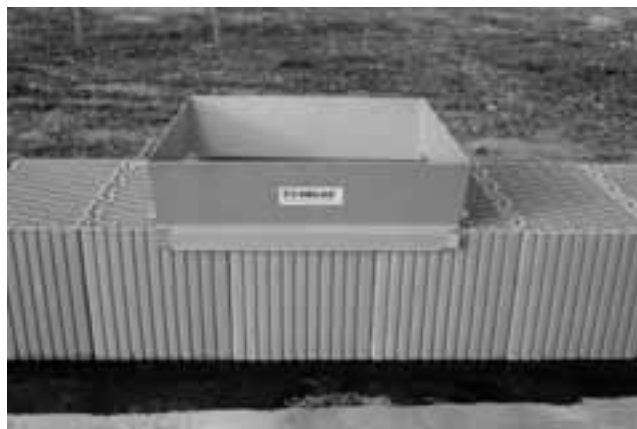
První vrstva cihel připravená pro zasypání perlitem.
