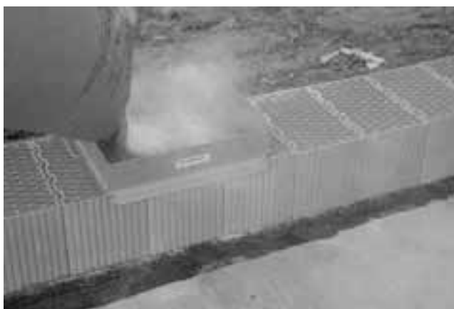
Sypání perlitu do maltovacího přípravku.
